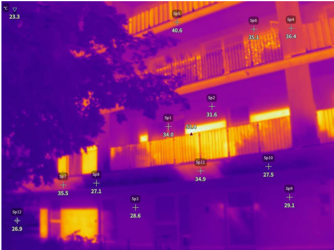
Abbildung 122 Oberflächentemperaturen an heißem Sommertag, besonnt, durch Bäume teilverschattet, durch auskragende Balkone teilverschattet, Hirschstetten 22. Bezirk
