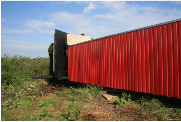
Abbildung 4: Fluchtunnel mit Blenden- und Beschattungs-konstruktion am Tunnelende. Rechts der Bildmitte ist das Fundament des Drehkranzes zu sehen.
