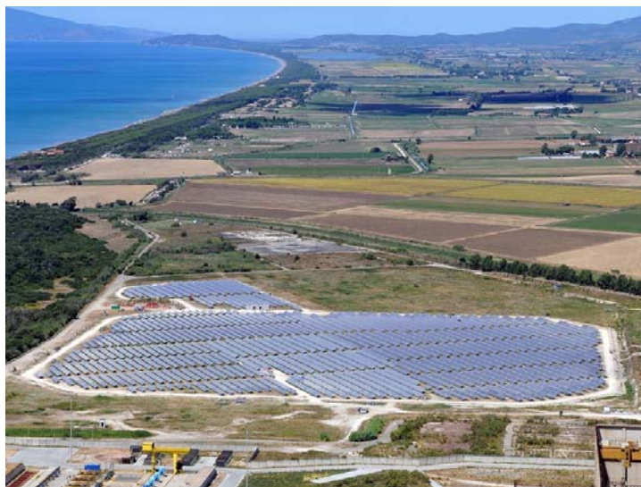
Abbildung 13: Solarpark Montalto di Castro, Italien, 84,2 MWp 24
