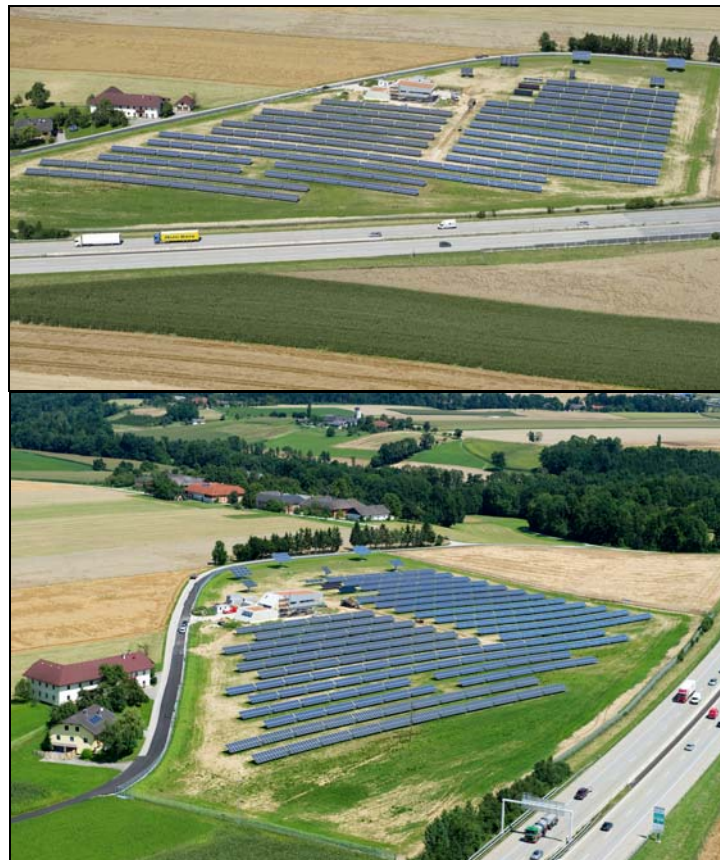
Abbildung 17: Photovoltaikkraftwerk Eberstälzell, OÖ, 1 MWp, gute Sichtbarkeit an der A1, Forschungsanlage, Freiflächenanlage auf 6 ha, Inbetriebnahme: 2010 27
