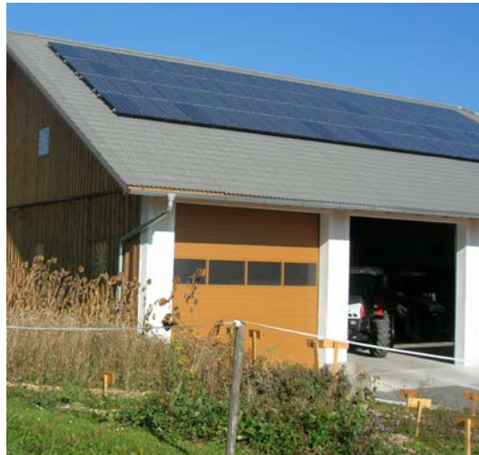
Abbildung 11: Energieautarker Bauernhof Friesenecker (bei Freistadt/OÖ), Photovoltaik-Solarstromanlage (12,5 Kilowatt peak, 10.000 – 12.000 kWh) 20
