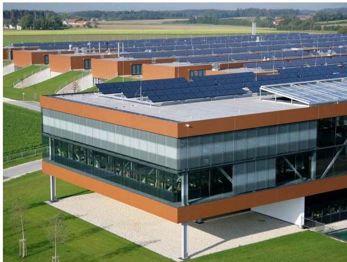
Abbildung 6: Photovoltaik-Anlage Fronius Standort Sattledt, OÖ, Anlagengröße 615 kWp, Inbetriebnahme 2007, Jahresproduktion 680 MWh, Module 2700 Sanyo HIP 215, Modulfläche 3.823 m 2 18
