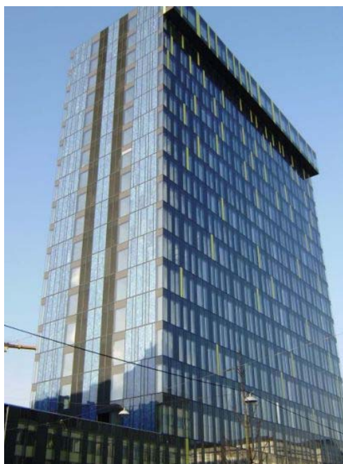
Abbildung 7: Power Tower Energie AG in Linz, Energieeffizientes Bürohochhaus mit 700m 2 fassadenintegrierter PV-Anlage an der Südwestseite, Module: 252 polykristalline VSG-Module (1.090 x 3.710 mm), Installierte Fläche: 638 m 2 , Installierte Leistung: 66 kWp, Energieertrag: ca. 42.000 kWh/a 19
