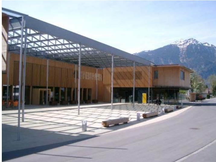
Abbildung 8: Gemeindezentrum in Ludesch, Transluzente Photovoltaik als Dorfplatzüberdachung, Module: 120 Verbundsicherheitsglas-Module von Ertex-solar, Installierte Fläche: 350 m 2 , Installierte Leistung: 19,08 kWp, Energieertrag: 16.000 kWh/a 19
