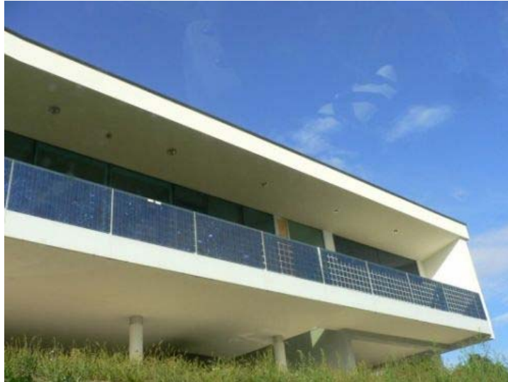
Abbildung 10: Wohnhaus am Hang (Passail), Stromerzeugende Brüstung mit Punkthalterung aus Edelstahl, Module: 20 Verbundsicherheitsglas-Module (1.555 x 2.000 mm) von Ertex-Solar, Installierte Fläche: 60 m 2 , Installierte Leistung: 4,7 kWp 19
