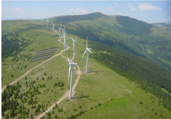
Abbildung 16: Geplanter Solarpark Oberzeiring, Österreich, 2 MWp, auf einem rund 1.900 m hohen und nach Süden ausgerichteten freien Bergrücken, seit 2006 komplett bewilligt, für Realisierung muss auf wirtschaftliche Einspeisebedingungen gewartet werden, Anlage soll als Freiflächenanlage in einem Abstand von ca. 100 m südlich der Windkraftanlagen 6-8 errichtet werden, geplante Fläche beträgt 400x150 m, Wirkungsgrad der PV- Anlage unter diesen klimatischen Bedingungen ist höher als an Flachlandstandorten 26
