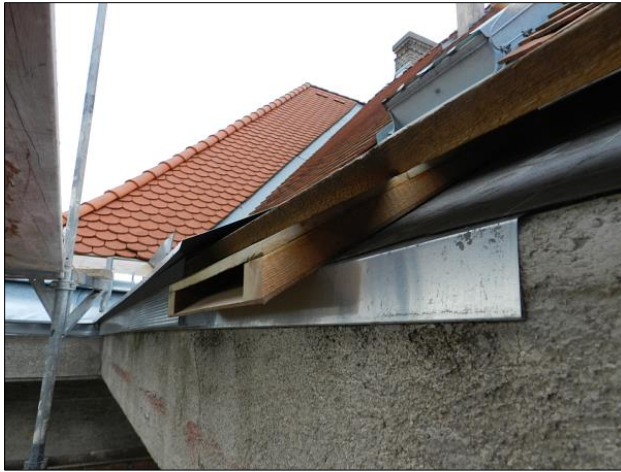
In das Zwischendach eingeschobene Spaltenquartiere für Fledermäuse
