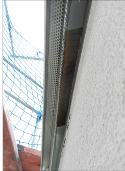
In das Zwischendach eingeschobene Spaltenquartiere für Fledermäuse
